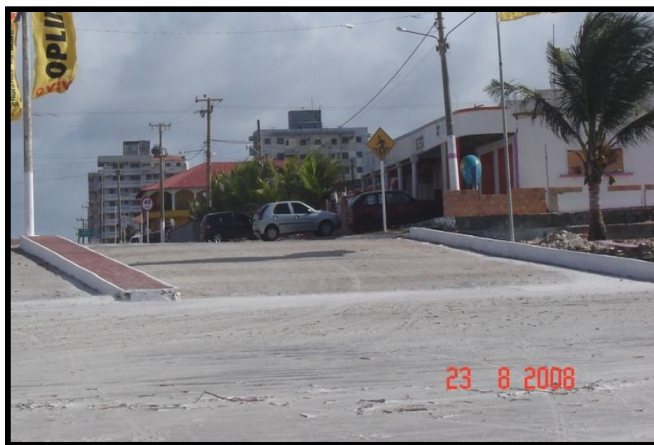
Foto 26 – Rampa de acesso a praia Fonte: MELLO, E. Agosto, 2008
