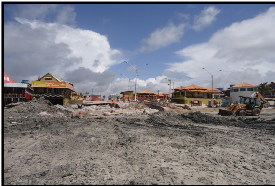
Foto 33 – Recuperação das rampas de acesso para a Praia Visão praia para orla Fonte: Souza.D. Junho/2013
