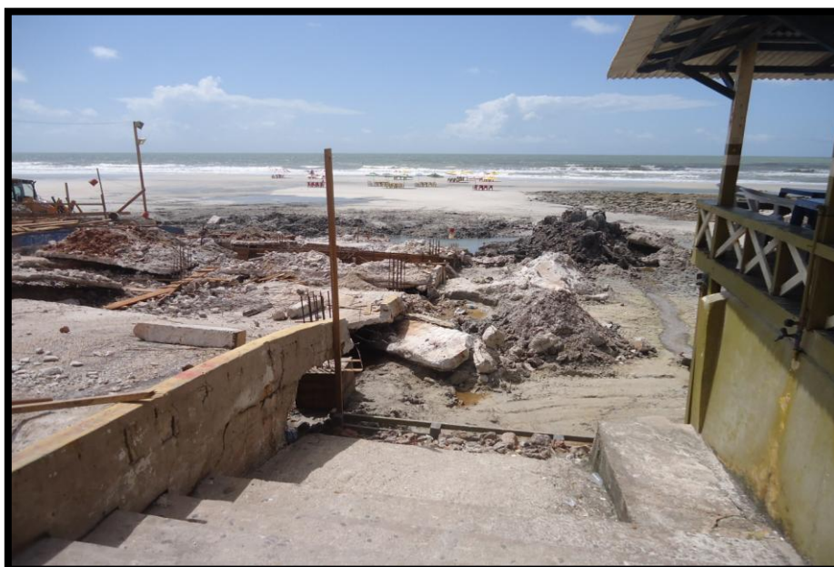
Foto 34 – Recuperação das rampas de acesso para a Praia Visão orla para praia Fonte: Souza.D (Junho/2013)
